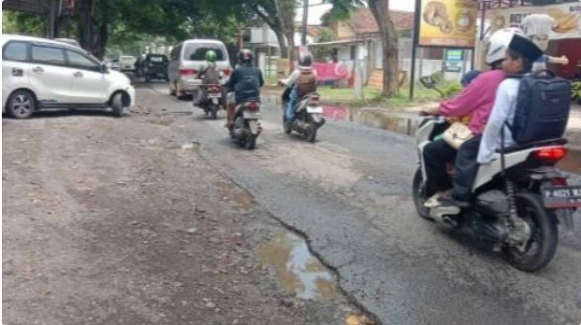
(Kondisi ruas Jalan Kepiting Kelurahan Tukangkayu, Banyuwangi)
